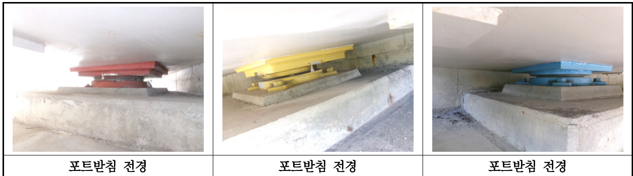
【사진 13.3.10】 교량받침 전경
