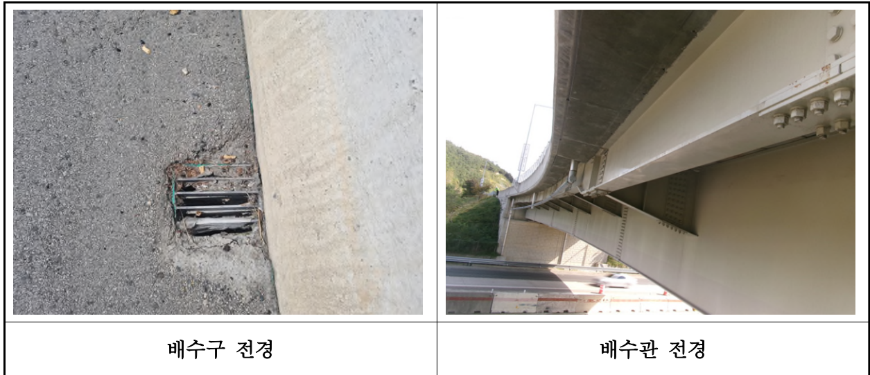
【사진 13.3.19】 배수시설 전경
