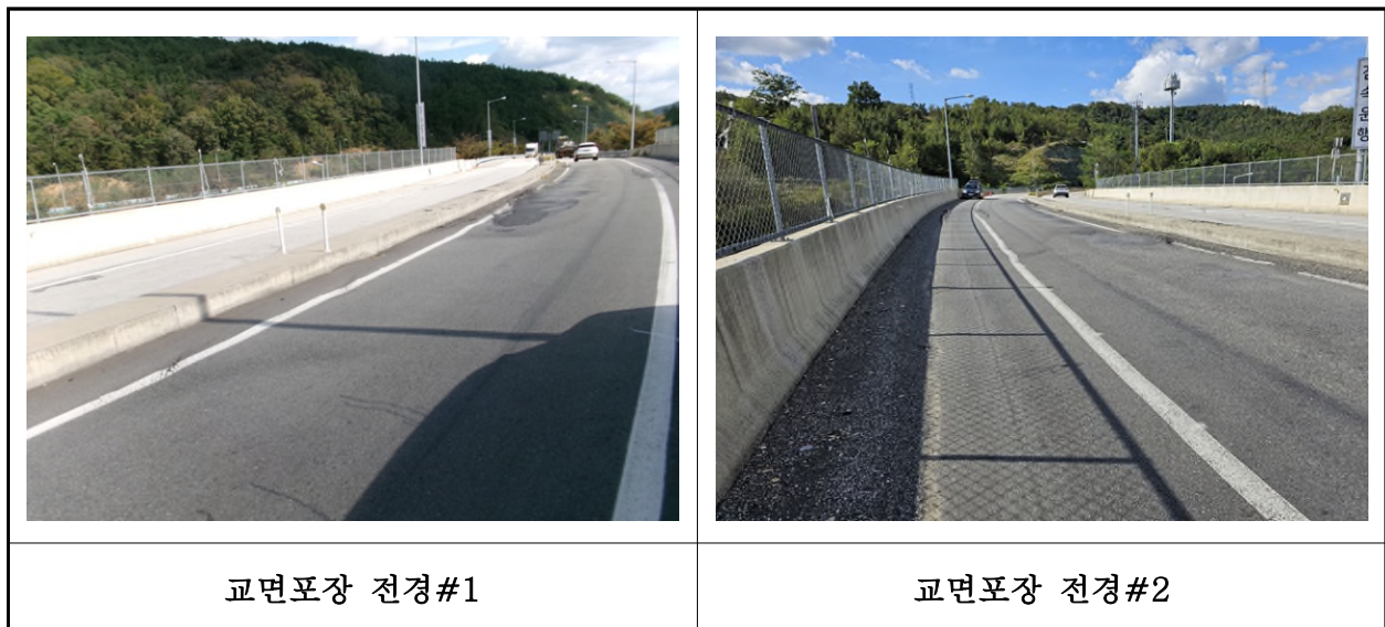
【사진 13.3.17】 교면포장 전경
