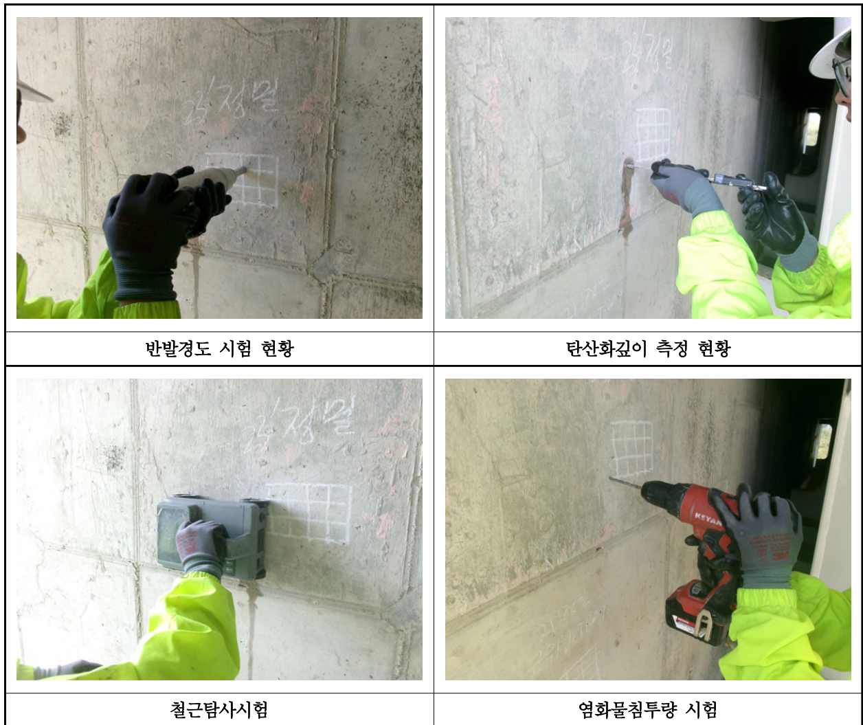
【사진 13.4.1】 콘크리트 내구성조사 현황
