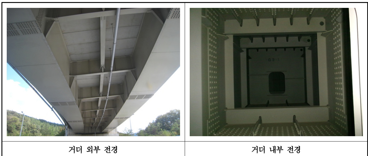
【사진 13.3.4】 거더 전경
