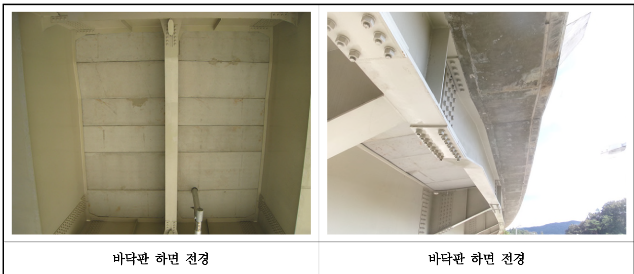
【사진 13.3.2】 바닥판하면 전경
