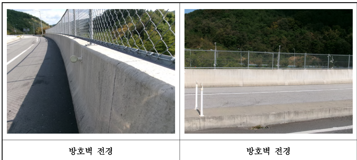
【사진 13.3.21】 방호벽 및 중앙분리대 전경
